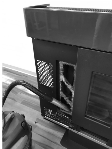
Fig. 38 - Limpeza da câmara de fumos
