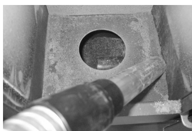
Fig. 31 - Limpeza do compartimento da gaveta de cinzas de cinzas
